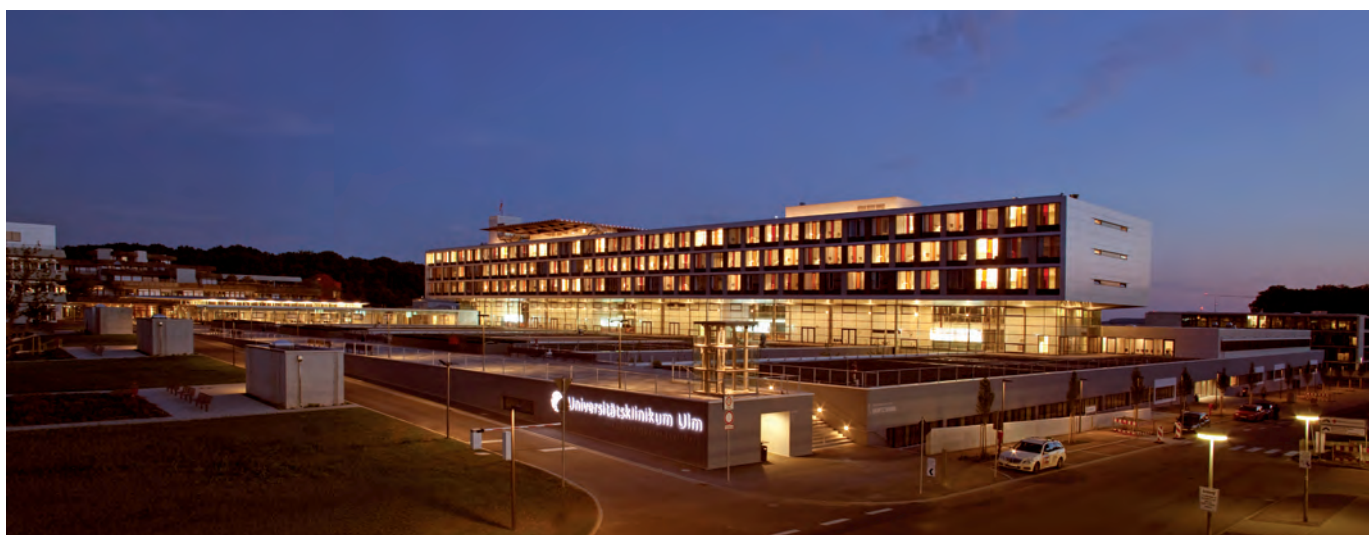
Abb. 1 Das Gebäude der Chirurgie/Dermatologie der Uniklinik Ulm bei Nacht.
